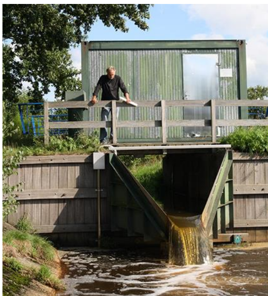
Figuur 14: Hupselse Beek, afvoermeetpunt Stuw 10A (WRIJ) met geijkte H-flume.
